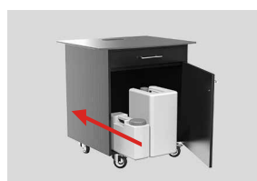
Beide Tanks wieder einsetzen und Schläuche einsetzen.
